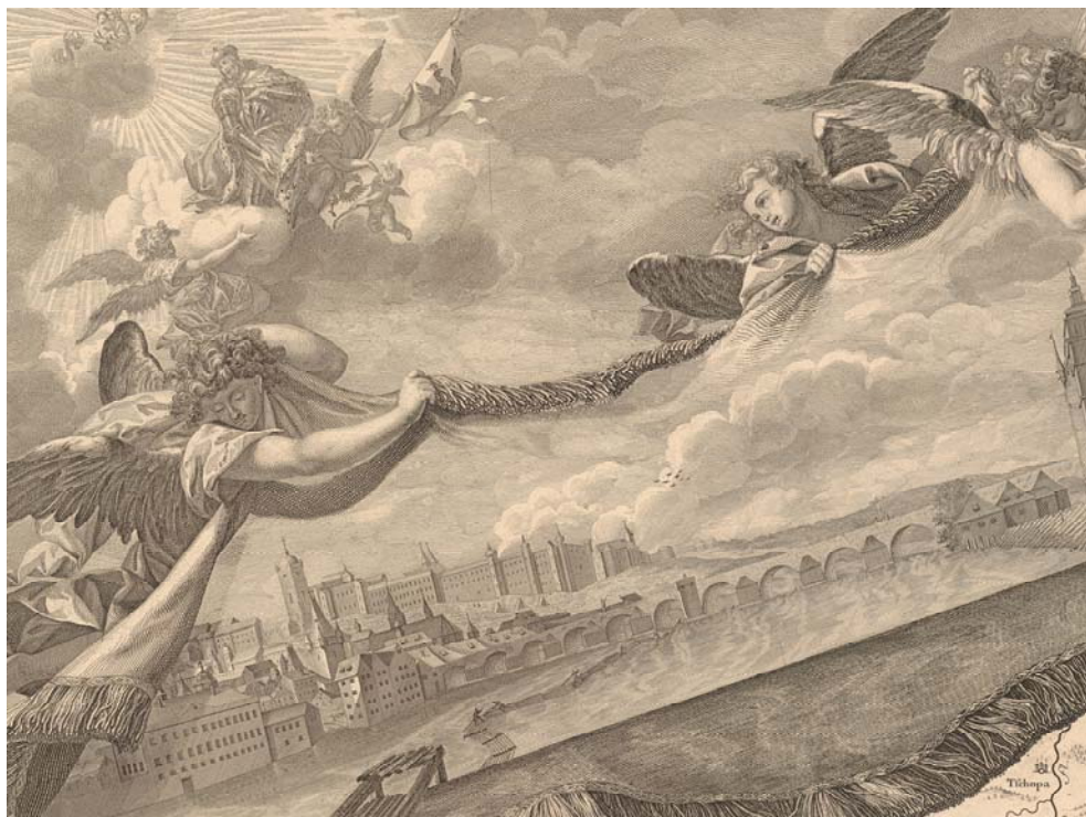
Obr. 2.2: Pohled na Karlův most a Pražský hrad, detail sekce I [B]
