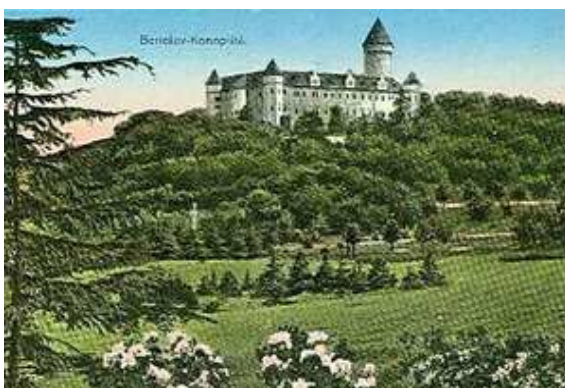
Obr. 10: JZ pohled ve 20. letech 20. st. [26]
