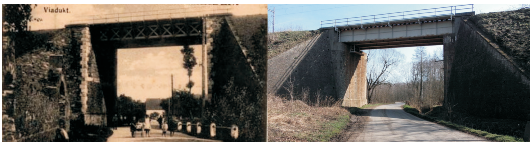
Obr. 2.10: Železniční most na území Mikulovic, cca r. 1935 [12], současnost
