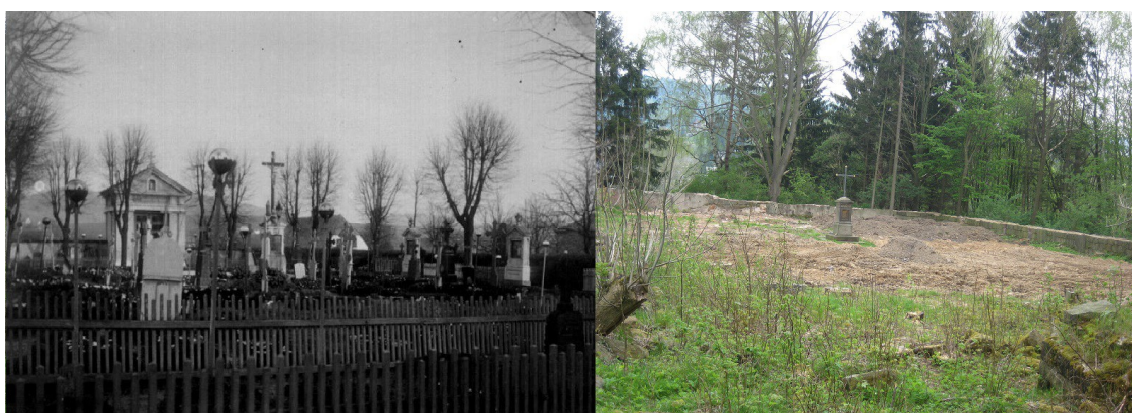
Obr. 6 Hřbitov – dříve a nyní (během obnovení), zdroj: TICHÝ, TRANTINA [4], vlastní
