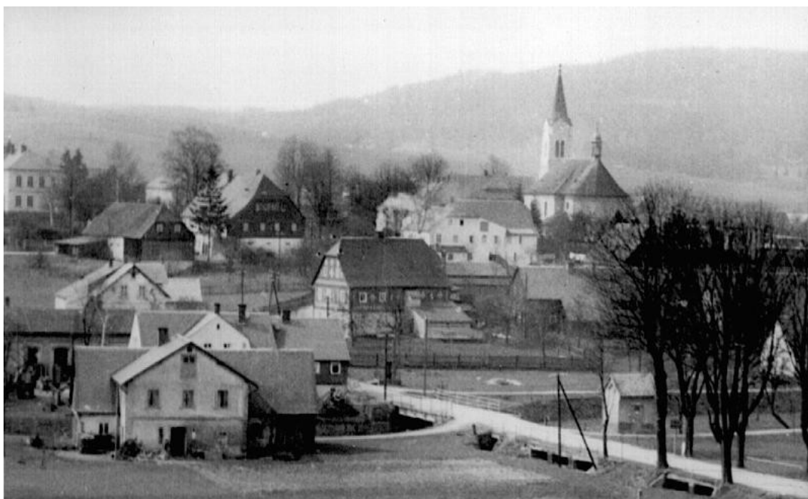
Obr. 4 Fukov – most přes řeku Sprévu, kostel , zdroj: TICHÝ, TRANTINA [4]
